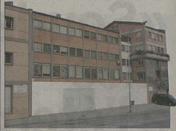
C'est sur ce futur mur frontal que l'artiste pourra laisser libre court à son talent. PHOTO-MONTAGE CLAIVAZ
